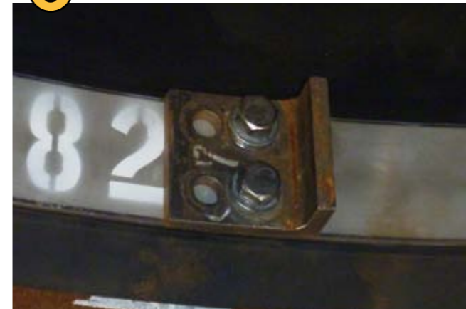
⑨ ジャッキ受け金具取り付け後
