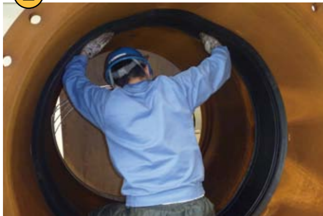
② 止水ゴムリング設置
