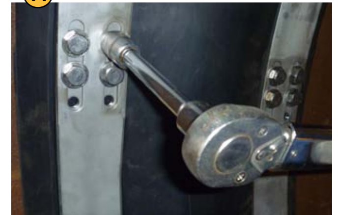
⑪ 締め付けトルク確認
