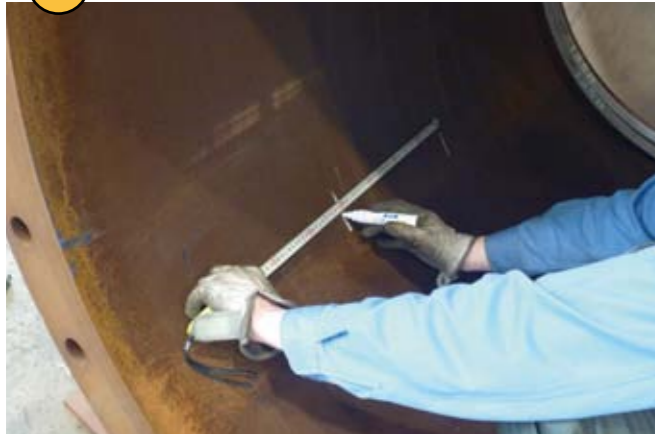
② 止水ゴムリング設置
