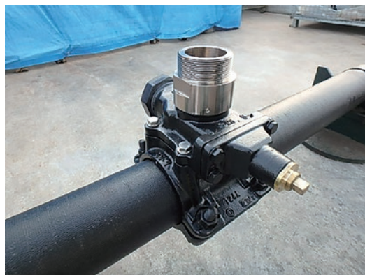
作業弁を取付けた状態
