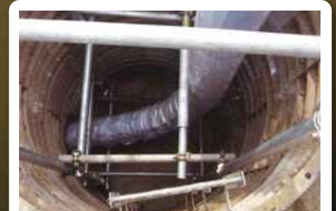
小さい立坑でも施工可能
