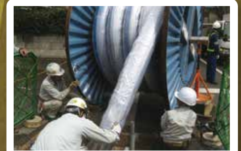
ドラム設置後引き込み開始
