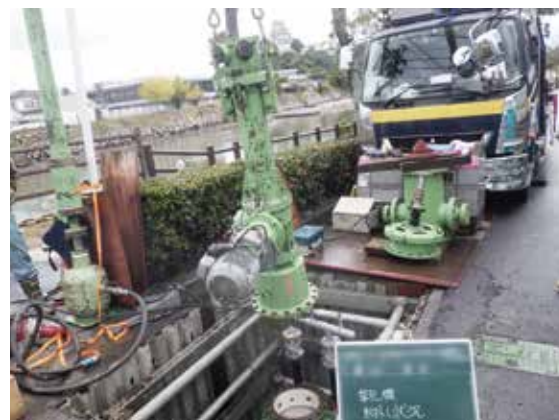
穿孔機取外し
