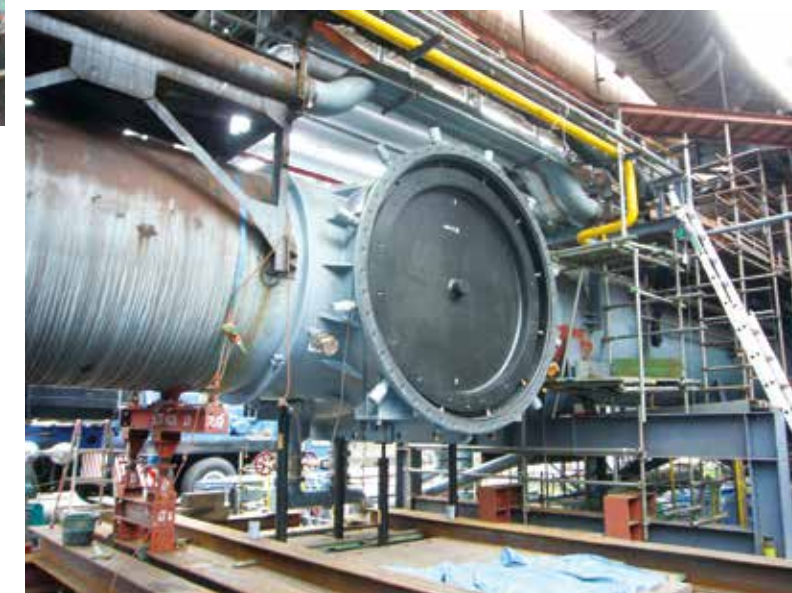
ノーフローボールバルブ設置工法 回転式放散管付
