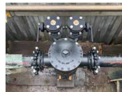
ノーフローボールバルブ設置工法 回転式放散管付
