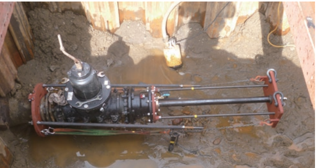
2. 作業用仮バルブ、挿入工具取付け
