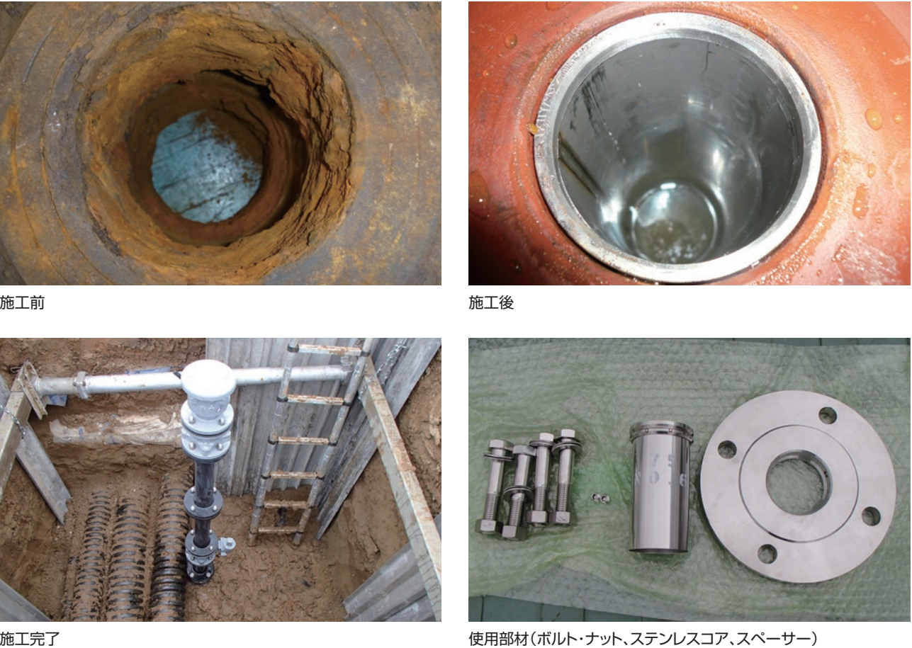
使用部材(ボルト・ナット、ステンレスコア、スペーサー)
