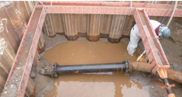
1. 分岐配管撤去前
