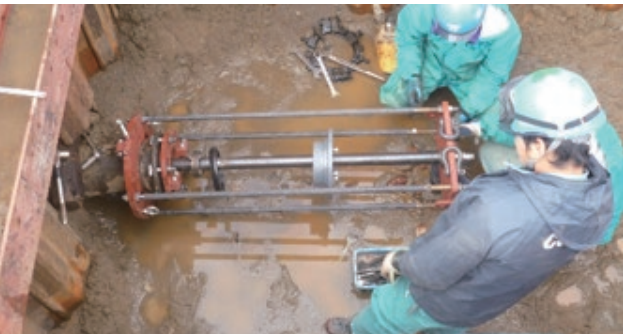
3. 分岐配管撤去、仮押輪取付け
