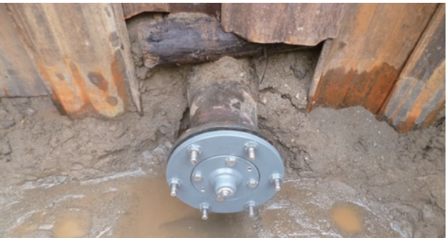
4. 押し付け押輪、蓋の取付け
