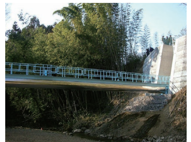
大久保暗渠併設水路工事 700A
