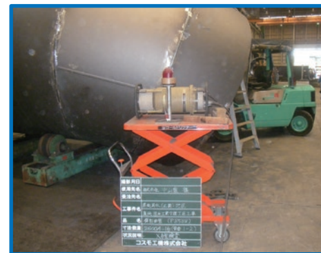
鋼製曲管φ2,600mm X線検査
