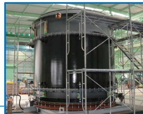
伸縮可撓管φ3500 耐圧検査
