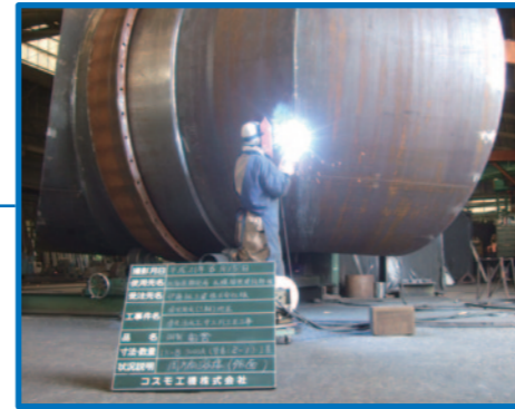
鋼板製異形管φ3000mm 溶接作業
