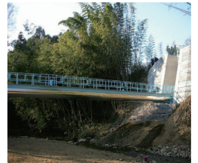
大久保暗梁併設水路工事 700A
