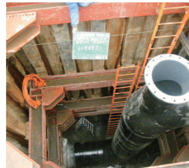
北総中央農業水利事業 1号送水路その2-1工事 1000A
