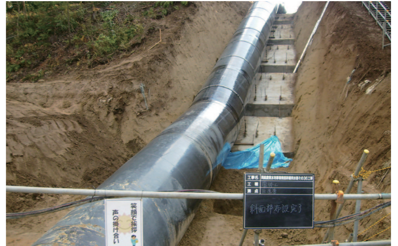
両総農業水利事業所 南部幹線用水路その36工事 2550A
