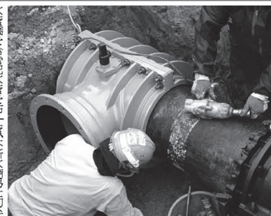
狭小スペースに耐震型ロータリーバルブを設置
