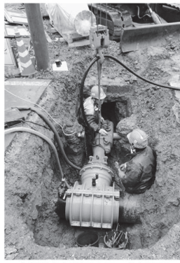
穿孔(上)と設置完了の状況(下)
