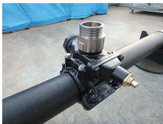
作業弁を取付けた状態
