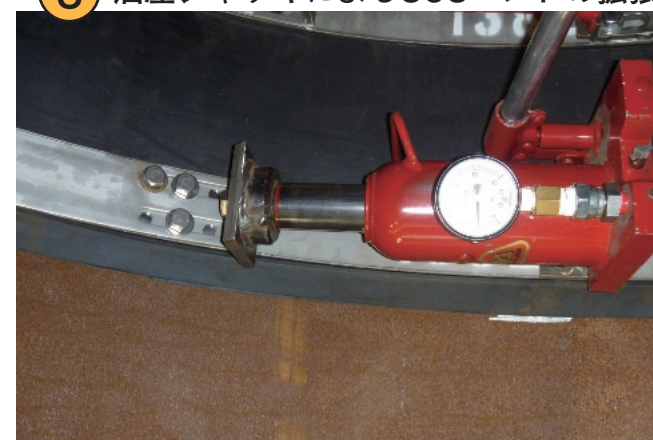
⑧ 油圧ジャッキによるSUSバンドの拡張
