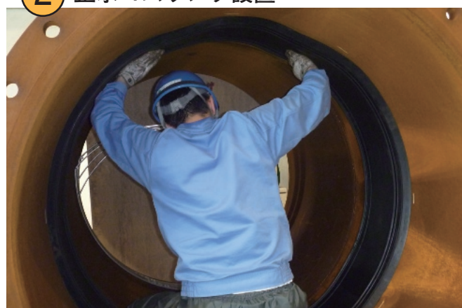
② 止水ゴムリング設置
