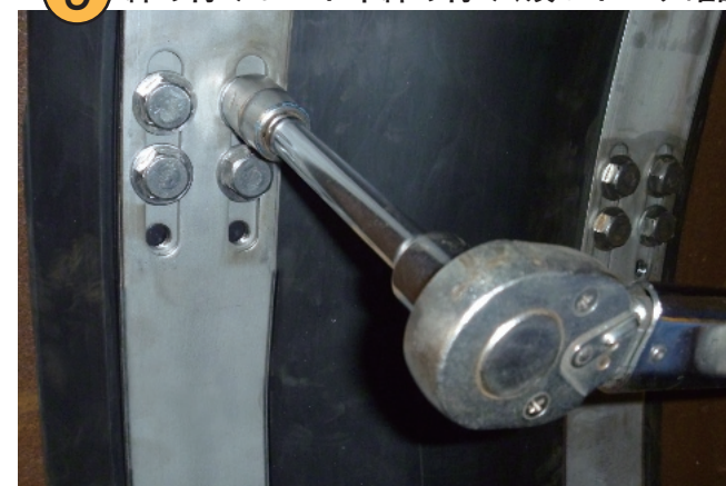
⑨ 締め付けボルト本締め付け、及びトルク確認
