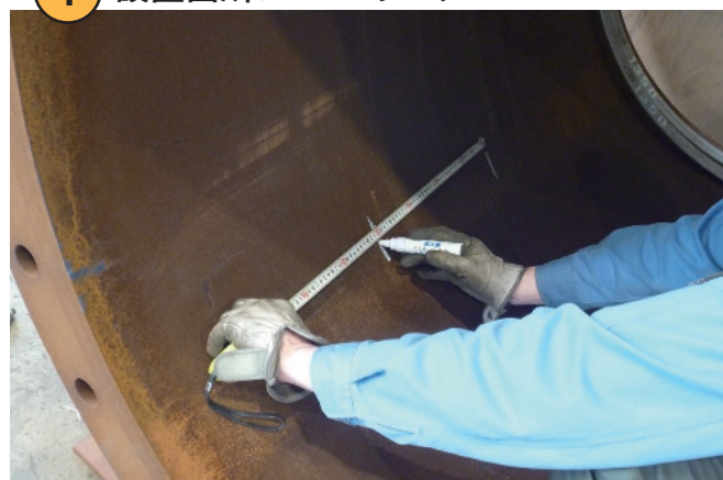
② 止水ゴムリング設置
