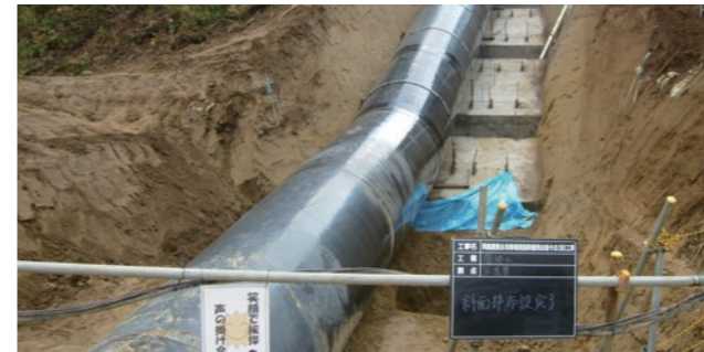
南部幹線用水路その36工事 2550A
