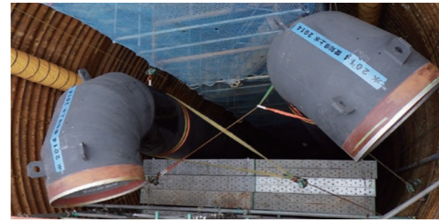
豊橋城下線第1工区(その2)外送水管製作接合工事①
