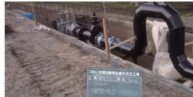
松瀨支線用水路 その2工事 300A
