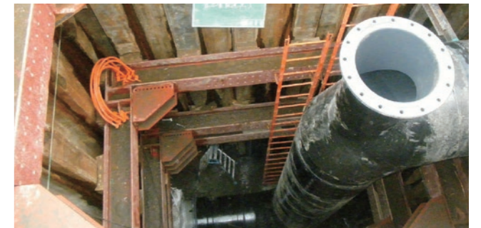
北総中央農業水利事業 1号送水路その2-1工事 1000A
