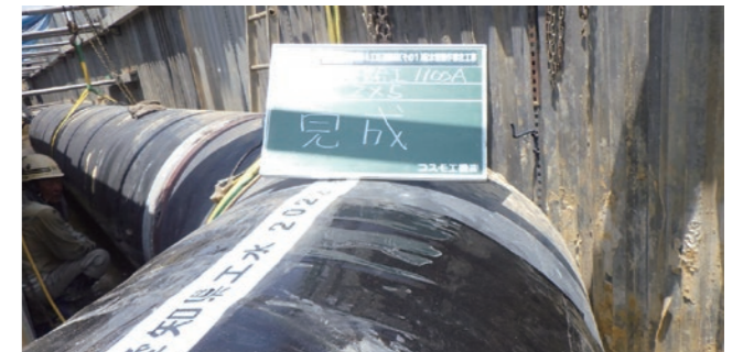
第2北部幹線第4工区連絡管配水管製作接合工事
