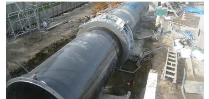
南部幹線用水路 その47工事 1500A
