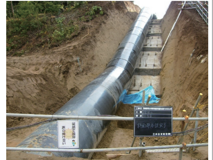
両総農業水利事業所様 南部幹線水路その36工事 2550A
