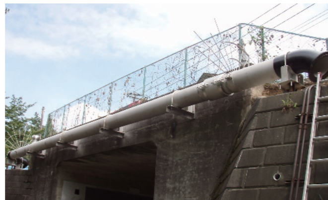
日野市様水管橋 SUS400A 架設工事
