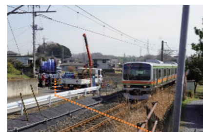
軌道横断箇所での施工
