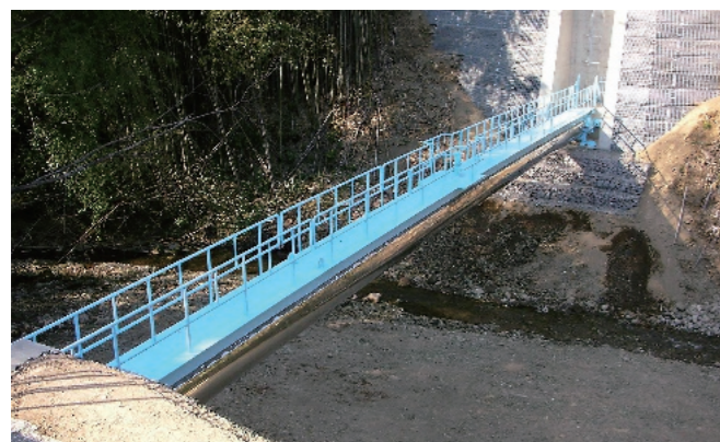
大久保暗梁併設水路工事 700A
