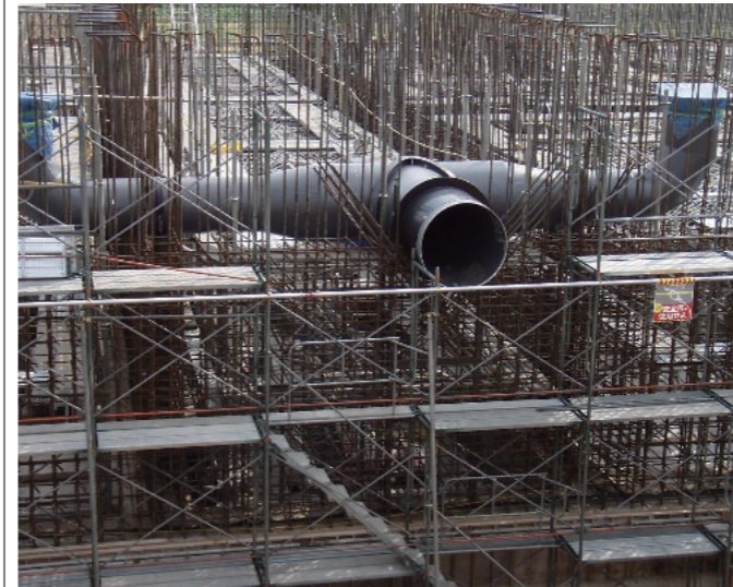
松田新田浄水場配水池築造工事
