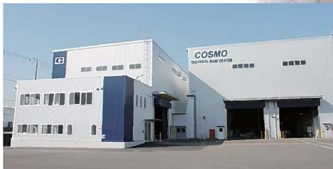
(上)東京・港区の本社ビル (左)コスモテクニカルベースセンター(CTBC、飯能市)は、製造や物流、エンジニアリング、研究開発、試験の複合拠点施設として2014年に稼働した。敷地面積は2万3702㎡で、2018年2月には新たにエンジニアリング2号棟(建築面積2380㎡)を整備した。
