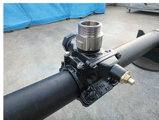
作業弁を取付けた状態
