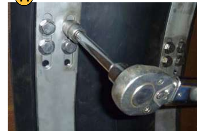
⑪ 締め付けトルク確認
