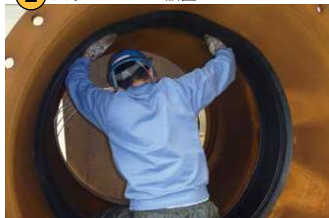
② 止水ゴムリング設置
