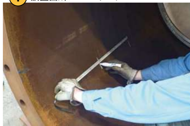
② 止水ゴムリング設置
