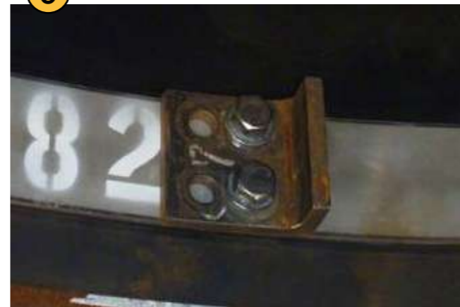
⑨ ジャッキ受け金具取り付け後
