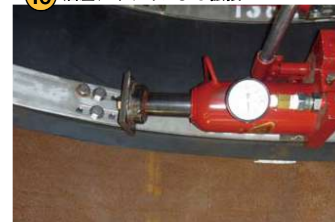
⑪ 締め付けトルク確認
