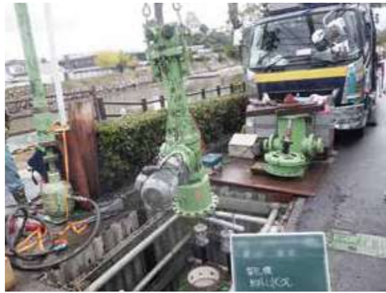
穿孔機取外し
