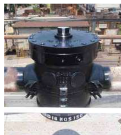
インサートボールバルブ φ150/中圧ガス 施工事例
