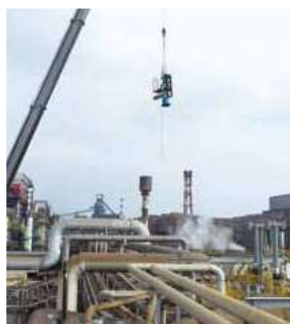
インサートプラグ φ2200/コークスガス 施工事例
