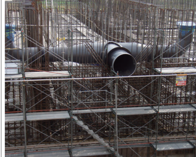
松田新田浄水場配水池築造工事
