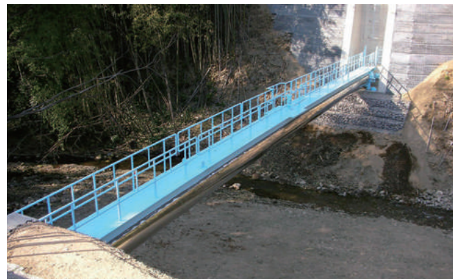
大久保暗梁併設水路工事 700A
