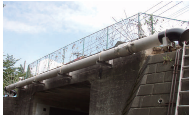
日野市様水管橋 SUS400A 架設工事
