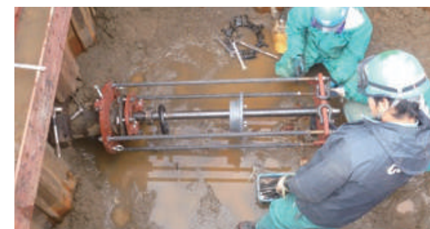
3. 分岐配管撤去、仮押輪取付け
