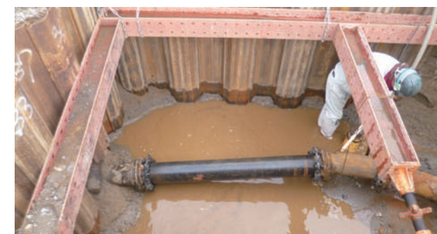
1. 分岐配管撤去前
