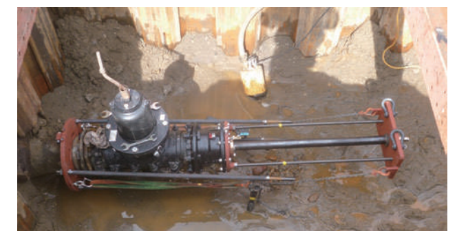
2. 作業用仮バルブ、挿入工具取付け
