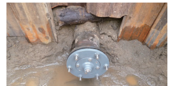
4. 押し付け押輪、蓋の取付け
