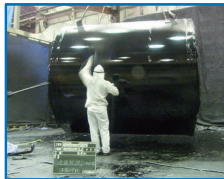
飲料水兼用耐震性貯水槽100t 塗装作業
