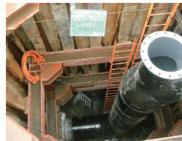
北総中央農業水利事業 1号送水路その2-1工事 1000A
