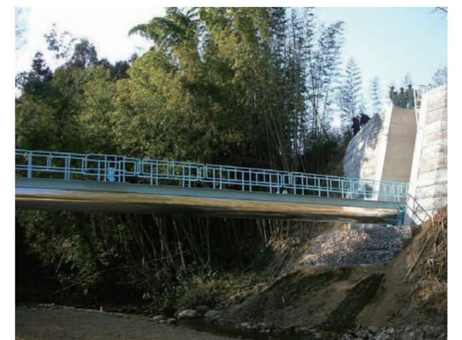
大久保暗梁併設水路工事 700A
