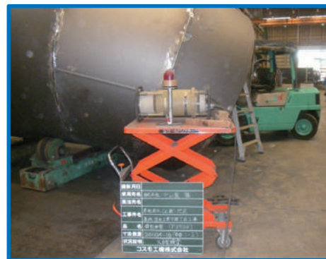
鋼製曲管φ2,600mm X線検査
