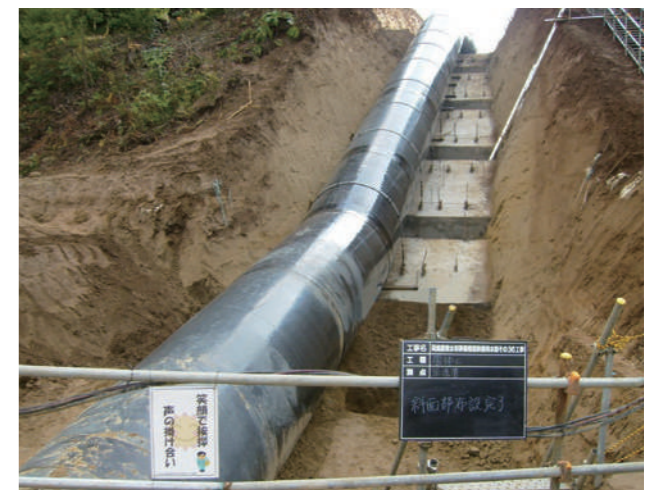
両総農業水利事業所 南部幹線用水路その36工事 2550A
