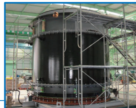
伸縮可撓管φ3500 耐圧検査
