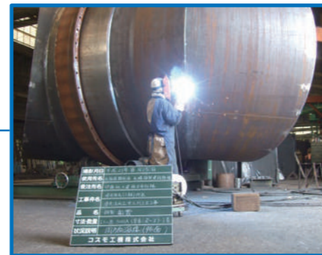
鋼製異形管φ3000mm 溶接作業
