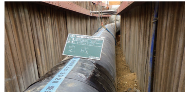
豊橋城下線第5工区(2-1)送水管製作接合工事
