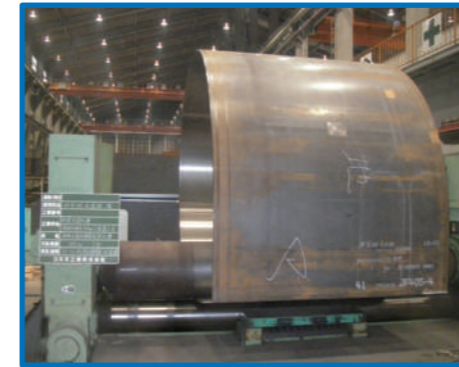
鋼板曲げ加工
