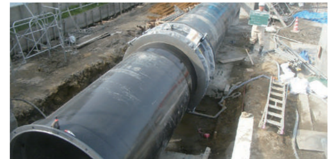
南部幹線用水路 その47工事 1500A
