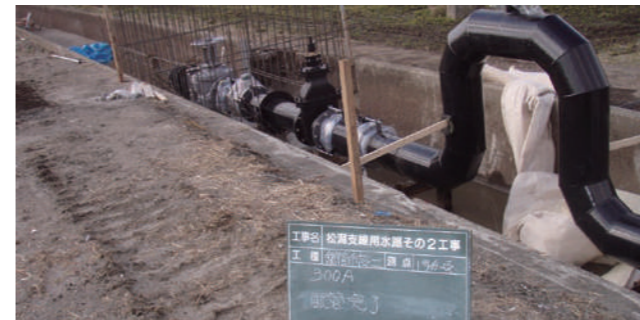
松瀨支線用水路 その2工事 300A
