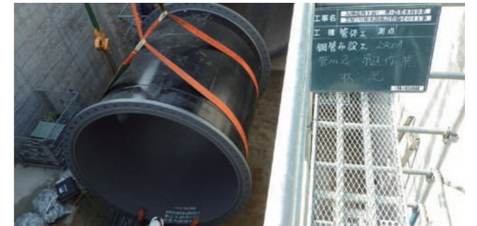
九頭竜川下流(二期)農業水利事業 芝原2号用水路施設整備その1工事 2400 A
