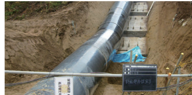
南部幹線用水路その36工事 2550A
