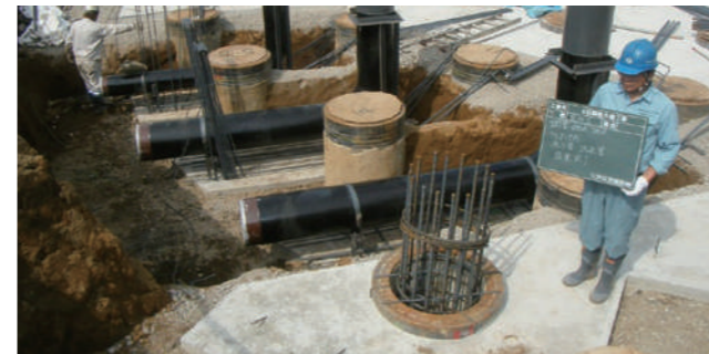
北総中央農業水利事業6号 調整水槽工事 450A 300A
