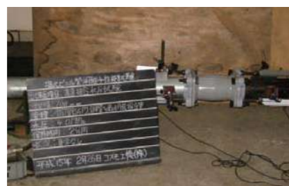
真直接合水圧試験(鋼管)
