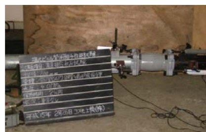
真直接合水圧試験(鋼管)
